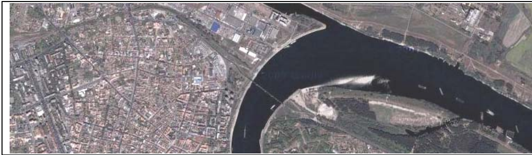
Slika 1: Novi Sad. Lokacija Železničko-drumskog mosta.
